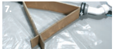
7. Einfassung erstellen und mit Montageschaum ausschäumen.
