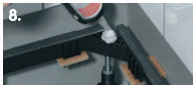
8. Auf die Winkelverbinder Sanitär-silikon geben und die Duschwanne aufsetzen.
