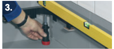
3. Die 4 Abstandhalter auf die unteren Laschen am Montagerahmen stecken und die Montagehöhe einstellen.
